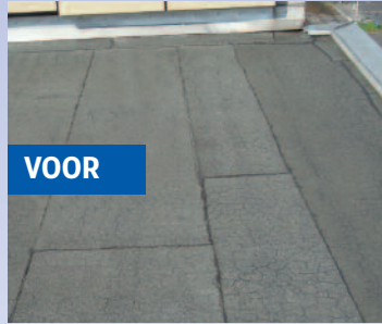
Hier is de ondergrond een bezande bitumenbaan.
