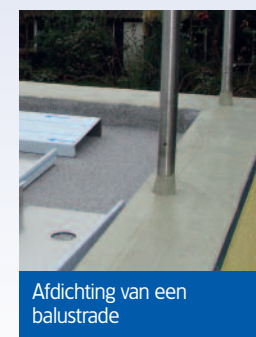
Afdichting van aansluitingen
